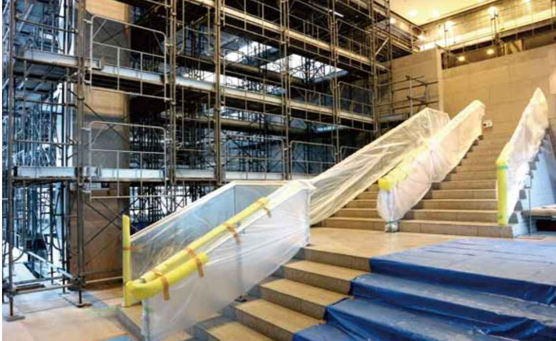
メンテナンス中の館内。普段は開放的な空間である地下1階屋内広場も、天井まで全面に足場が組まれている。
