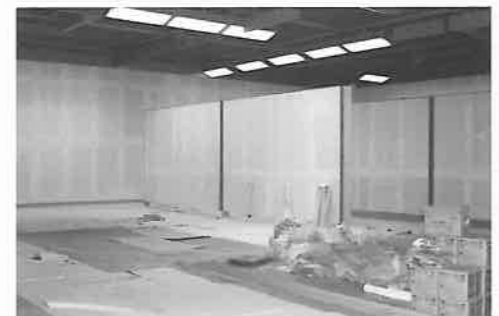
古いクロスが剥がされた2階展示室
