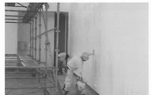
壁面塗装中の地下展示室
